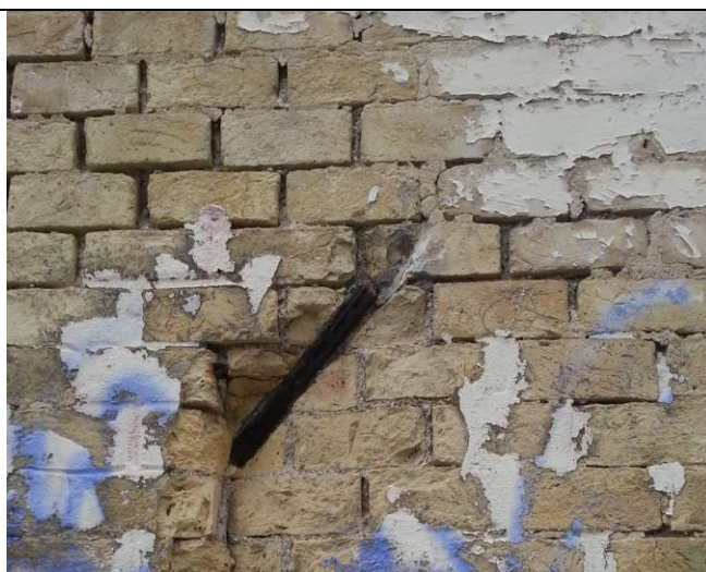
Figura 8 - Cuciture armate in corrispondenza di un martello murario (vista esterna)
