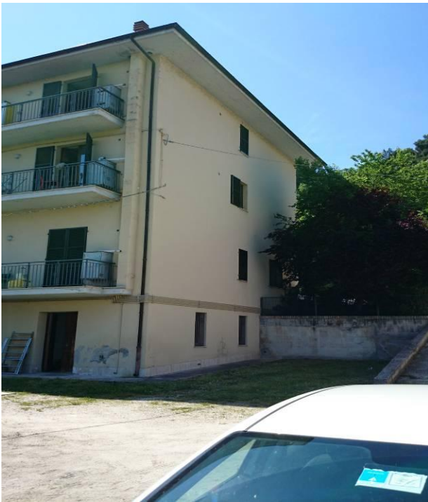
Figura 21 - Fronte laterale con visibile muro di contenimento
