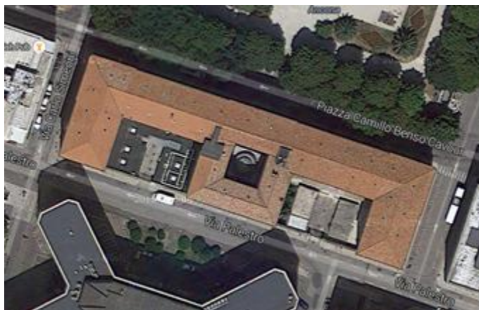
Figura 3 - odierna configurazione della copertura
