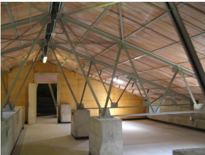
Figura 6 - Capriate metalliche di copertura
